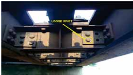
Fig. 2.32 Loose rivet
